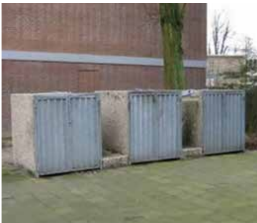
Verzamelcontainers voor diverse afvalstromen.
